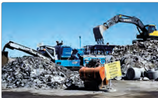
Kuva 3-28. Kuvassa on esimerkki betonijätteen murskauksesta.
