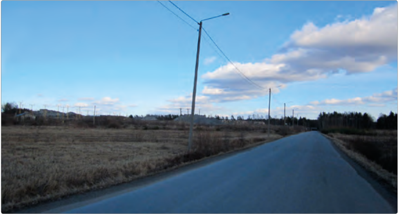
Kuva 6-20. Näkymä lännestä Vaistentieltä kohti Vaisten hankealuetta. Kuvassa etualalla alue A ja takana alue B. Kuvassa havaittavissa myös lentoaseman lähestymisvalot ja hankealueelle rakennetut meluvallit.
